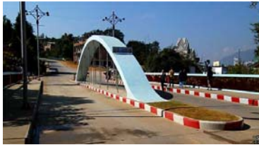
瑞麗・国境に架かる橋「腕町九谷橋」
